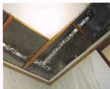
工事施工前(天井)
