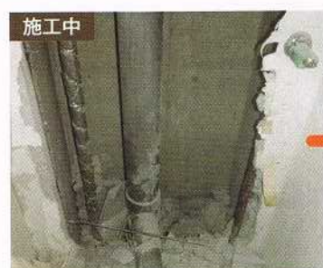
トイレの壁を壊した後、配管の取り換えを実施
