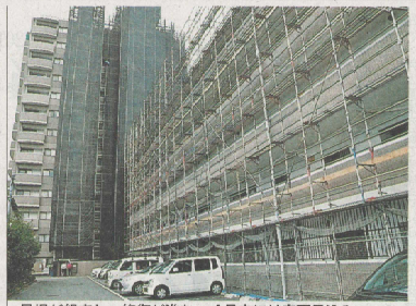
足場が組まれ、修復が進む。4月末には完了見込み
