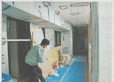
被害が大きかった7階地下も修復が進む
