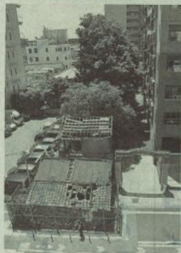
歩道をふさぐように突き出た 空き家＝さいたま市大宮区
